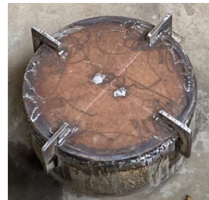
井戸への鉄板蓋取付状況
