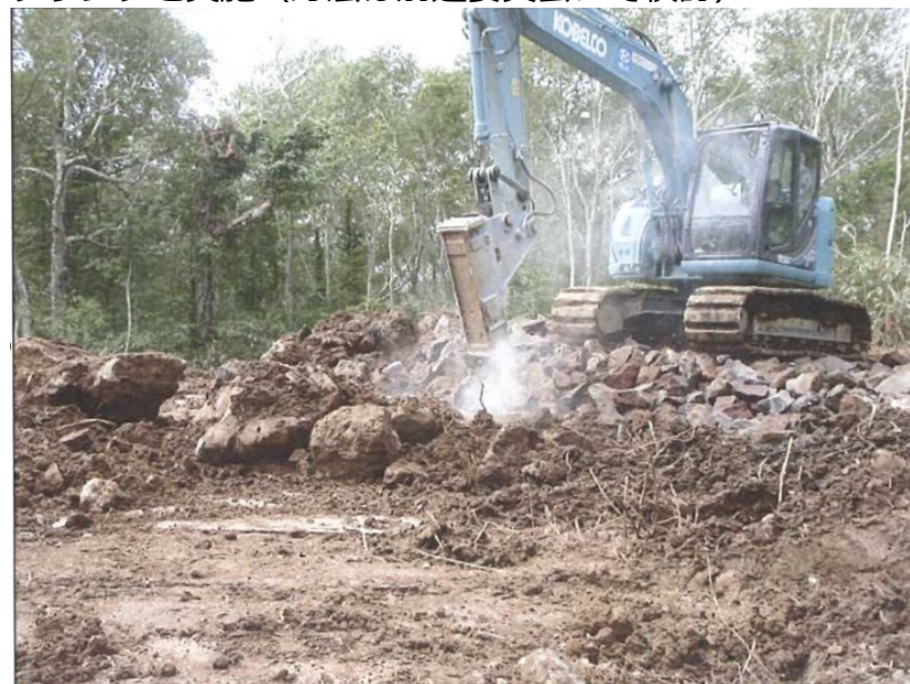
D基地敷地造成時写真 （蒸気噴出前の2022年撮影）
